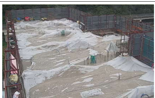
< 콘크리트 타설부위 비닐시트 설치 >
